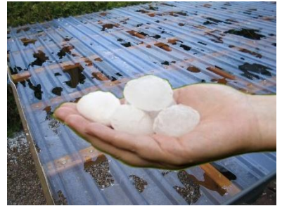
Normale PVC-Lichthaube Schlagzähigkeitskomponenten und UV-Stabilisatoren sind im Material verteilt und werden nach und nach abgebaut.
